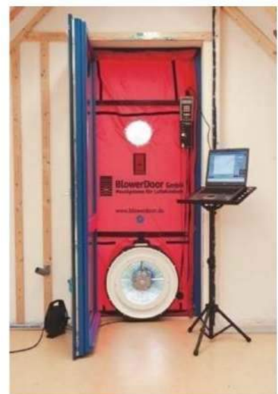
图 3.2: 已安装的鼓风机图（照片：BlowerDoor GmbH）
