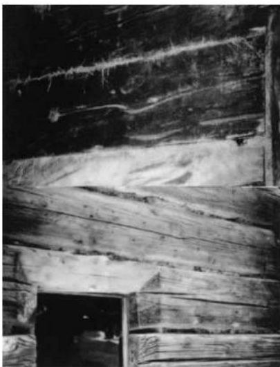
图 2.1: 在原木结构建筑上用藓苔和泥土堵塞缝隙。（照片：艾克-海尼希（Eicke-Hennig））
