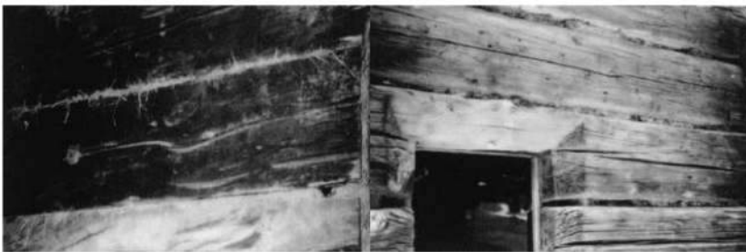
图 1.1: 在原木结构建筑上用苔藓和泥土作为密封材料填塞接缝和裂缝 (照片: Eicke-Henning)
