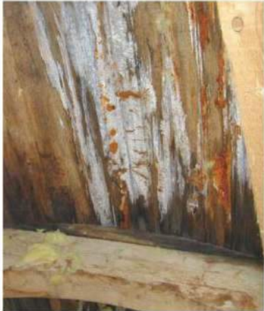
图 1.4: 由于气密层不够密封而被潮湿破坏的木质腹板 [9]。
