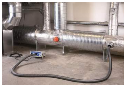
图5.37: 建筑工地上的密封性测试。[来源: Lindab 有限公司]
