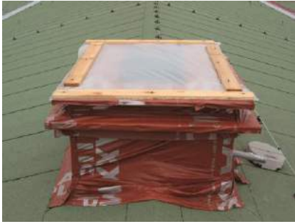
图 5.16: 屋顶上竖井的临时密封。[来源: 鼓风机测试有限公司]
