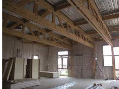
图 5.13: 用移动脚手架和梯子定位渗透处。
