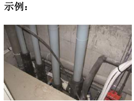
图 5.10：在工地视察时在建筑围护结构中发现的敞开的安装井。[来源：鼓风机有限公司]
