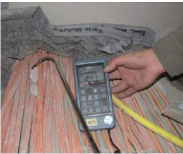
图 5.21：穿过一面分隔墙的线缆束。
