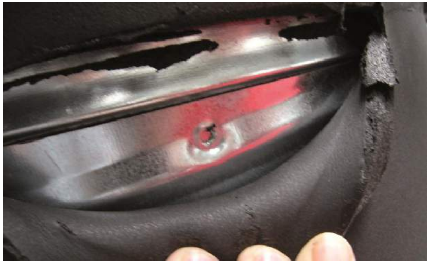
图 5.38: 未封闭的螺丝或铆钉孔。[来源: Lindab 有限公司]
