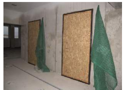
图 5.11：大型门洞用板材进行临时密封。[来源：鼓风机有限公司]
