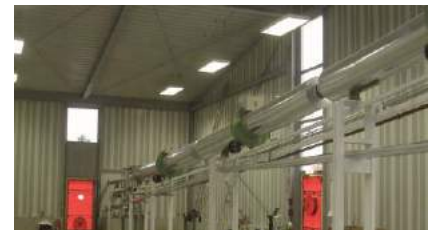
图 5.15: 在多个门洞中安装测量设备。[来源: 鼓风机有限公司]
