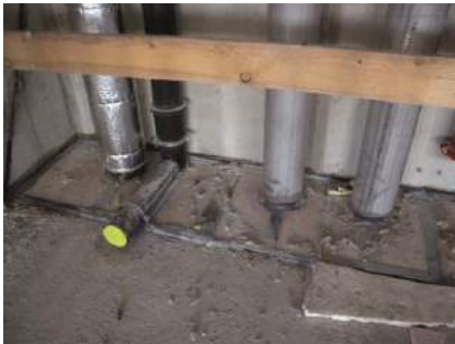
图 5.17: 安装井的临时密封。[来源: 鼓风机有限公司]
