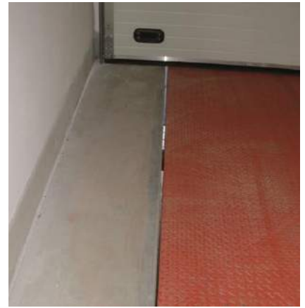
图 5.20: 厅堂中装卸桥和地面之间敞开的接缝。[来源: 鼓风机有限公司]
