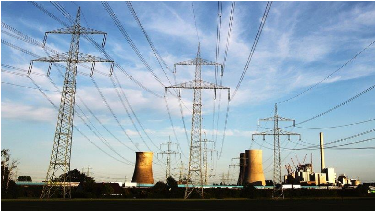
位于北莱茵-威斯特法伦州哈姆的莱茵-威斯特伐伦电力公司燃煤电厂前的输电线路架。
