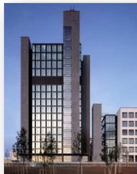
head office Stuttgart, Germany 德国巴登符腾堡州斯图加特总部
