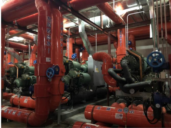
中国节能为雄安市民服务中心创造性地提出了“能源供应+环境治理”的综合解决方案。其综合能源系统，由能源供应系统、生活污水处理系统两大系统组成。能源供应系统，遵循“成熟技术+系统创新”的设计理念，实现了安全、绿色、清洁、高效的供能目标。根据土壤冬暖夏凉的特点，通过 1510 根、深 120 米、总长超过 25000 米的地理管，从土壤中提取浅层地温能，为整个园区提供 70%—75%的供能来源。根据生活污水冬夏两季与环境温度差大的特点，从园区每天产生的生活污水中提取能量，作为辅助供能来源。同时根据河北地区昼夜峰谷电价差大的特点，通过设置 1500 立方米的蓄能水池进行储能调节，夜间蓄能、白天释能，进一步降低电费支出。在夏季，系统还可以通过回收空调循环水中的热量，变废为宝，为整个园区免费制备生活热水。
