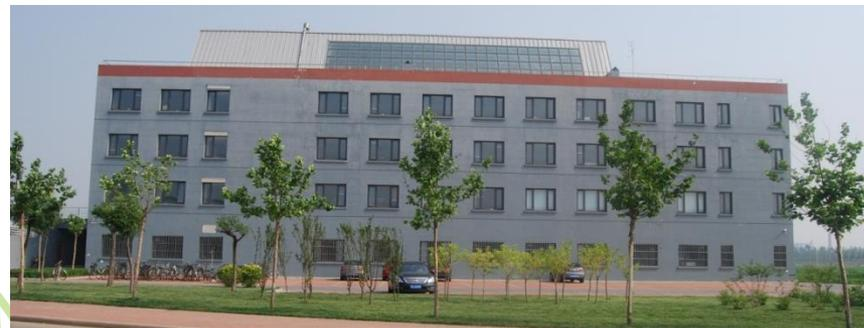
节能楼建筑面积4953.4 平米，建筑高度22米，地上4层，朝向为南北向偏东21度，两个相互独立的地理管群。其中，土壤源热泵地埋井66口（双U型管）、深度120米；太阳能辅助系统太阳能集热器面积280平米，地埋管井25口、深度50米。单位面积投资约400元。
