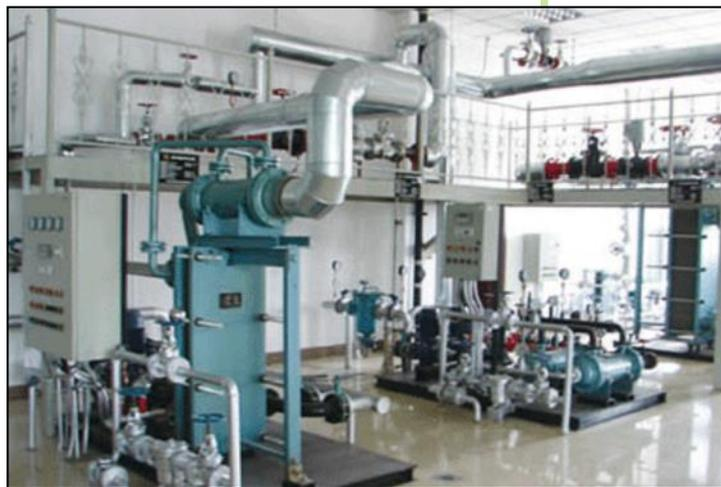
B、换热站：高校供热面积多在百万平方米以上，根据建筑功能和建筑供热特点，建设二次换热站，可有效解决热网的热力不平衡问题，并有助于实现供热节能。
